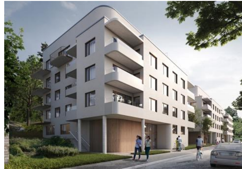
Nockebyskogen för SKB, byggstart 2020
