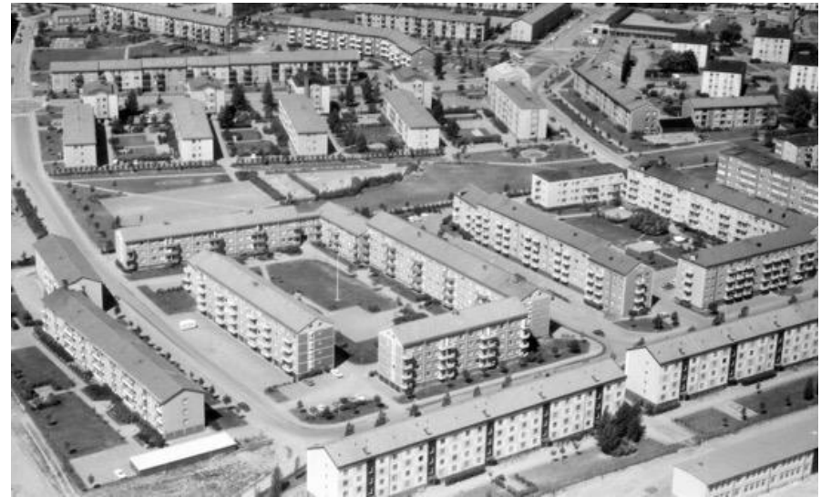
Renovering, Salabackar, Uppsalahem
